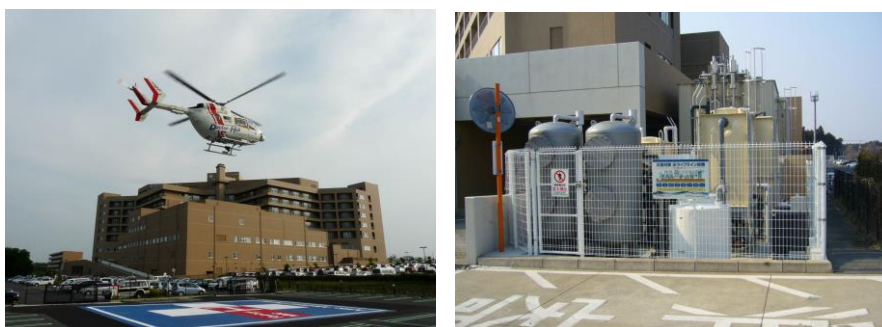
水戸医療センター外観（左）と導入した「地下水膜ろ過飲料化システム」（右）
