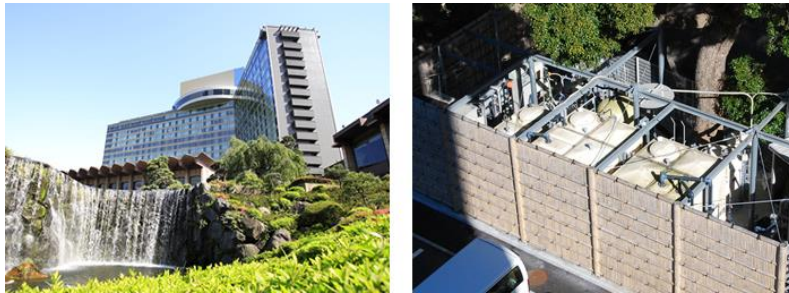
ホテルニューオータニ外観（左）と導入した「地下水膜ろ過飲料化システム」（右）
