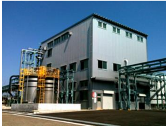
図 4 AQSOA®Z02 製造設備(新潟県上越市)
