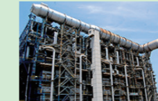
エチレンプラント
