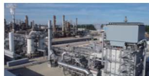
水素を供給するHyCO ® プラント
