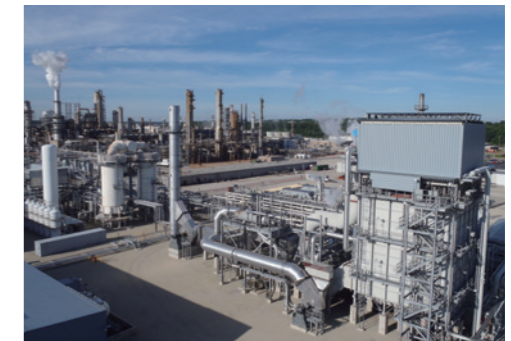
水素を供給するHyCOプラント
