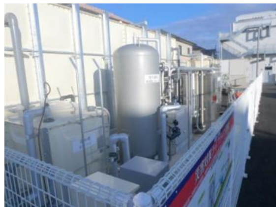
【医療法人田中会 武蔵ヶ丘病院の設備全景】
