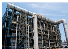
エチレンプラント
