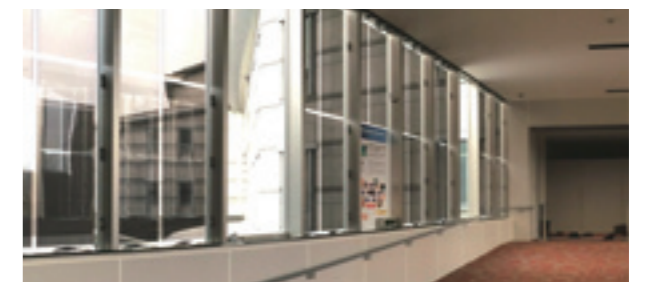
OPV施工例 (仙台国際センター)
