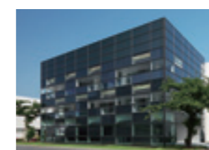
OPV施工例 (ZEB実証棟: 大成建設株式会社)
