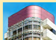
アモルファスシリコン型太陽電池 採用例 JR目黒グリーンビル(東京都品川区) 施主様：株式会社ジェイアール東日本ビルディング様
