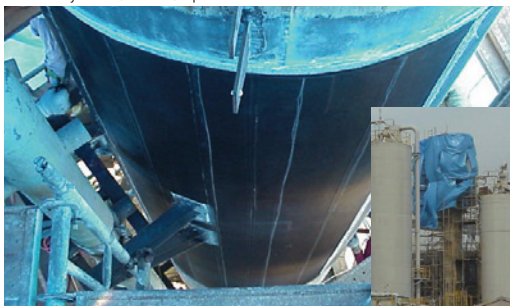
"SAKAIDE Plant, Kagawa JAPAN"
