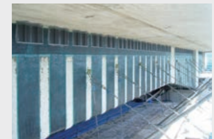
施工中の源太橋
