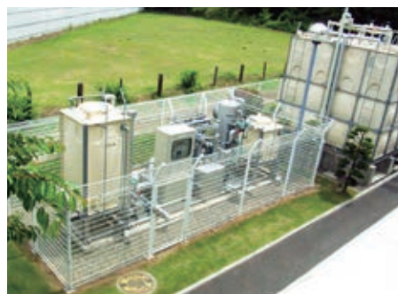
分散型水処理・給水システム
