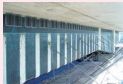
施工中の源太橋
