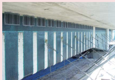
施工中の源太橋
