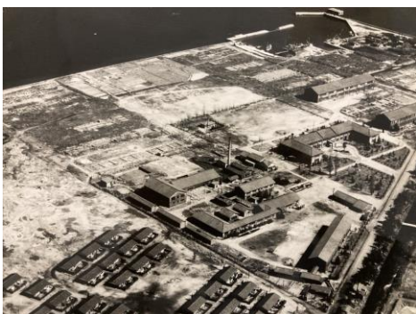
昭和33年3月ボンネル工場着工前
