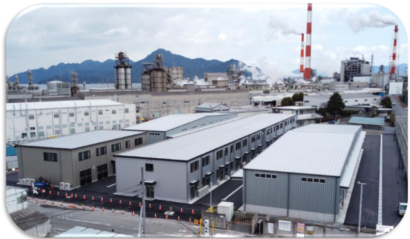
協力会社棟の外観
