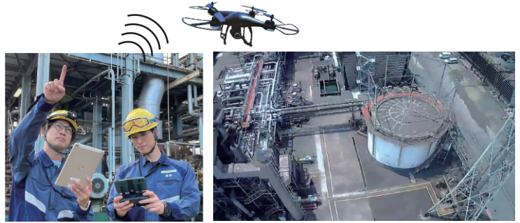
●小型ドローンを活用した外観点検 (上空から撮影することでアクセス困難な箇所が容易に点検可能)
