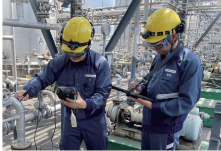
●タブレット端末と検査装置を連携した設備検査 (検査記録のデジタル化による効率的なデータ管理)
