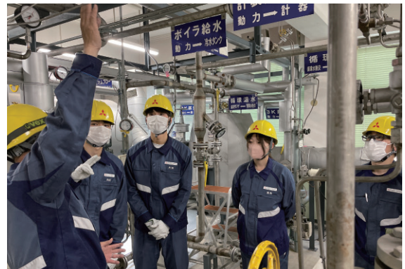
温水循環プラントでの運転操作基本教育
