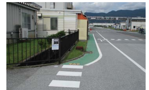
浸水深看板設置
