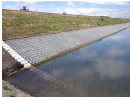
「ゴビマット®」が敷設された川内沢川
