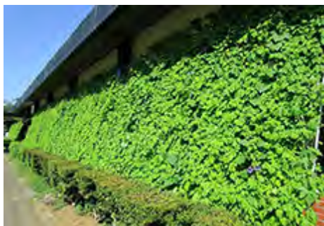
事務所棟に設置した「緑のカーテン」
