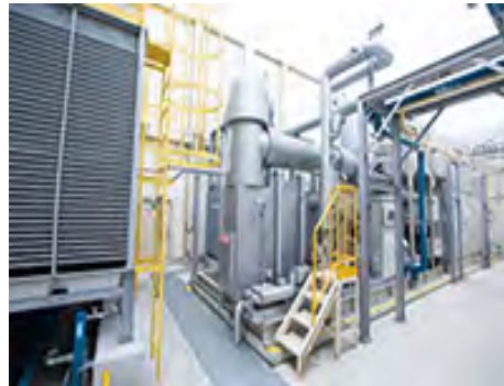
長浜工場に設置したコージェネレーション設備 エネルギー排出量の削減と緊急災害時などの自家発電が可能
