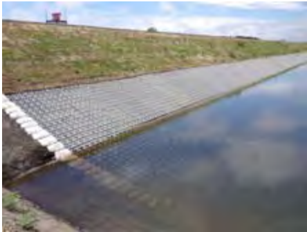
「ゴビマット®」が敷設された川内沢川
