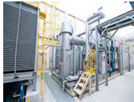
長浜工場に設置したコージェネレーション設備 エネルギー排出量の削減と緊急災害時等の自家発電が可能
