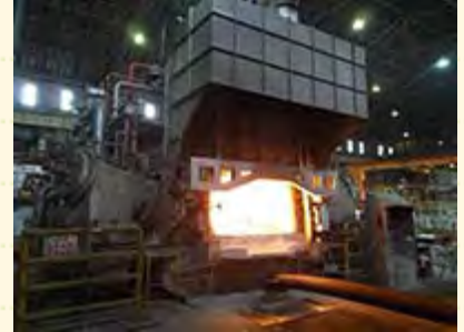
鑄造課の溶解炉設備
