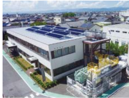
ゼオライト系水蒸気吸着材「AQSOA®」を使用した 冷暖房実証試験システム
