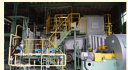
改造工事を実施したボイラー
