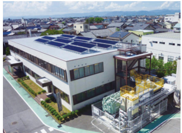
ゼオライト系水蒸気吸着材「AQSOA®」を使用した冷暖房実証試験システム
