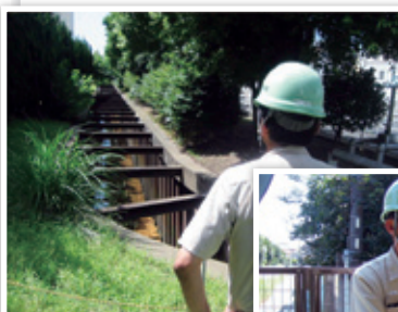
真土排水路の 日常パトロール
