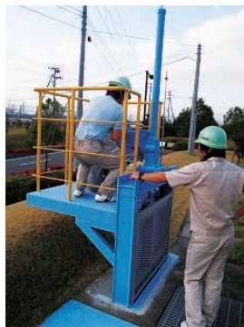
堰止めゲートの閉鎖
