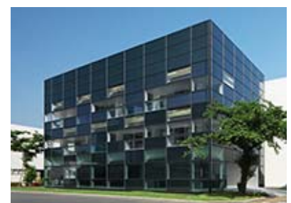
大成建設株式会社 ZEB実証棟 有機薄膜太陽電池外壁ユニット
