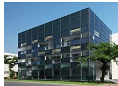
大成建設株式会社 ZEB実証棟 有機薄膜太陽電池外壁ユニット
