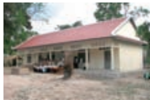
完成した校舎(アンロンク・チョア小学校) (写真提供:シャンティ国際ボランティア会)
