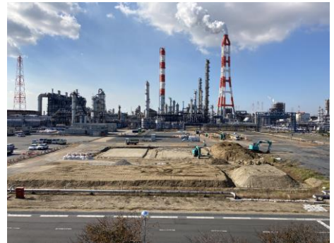
茨城事業所にケミカルリサイクル設備を建設中
