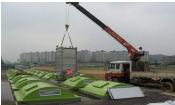
韓国天安市の大型水処理場
