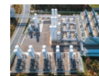
半導体産業に窒素を供給する「ASU (空気分離装置)」
