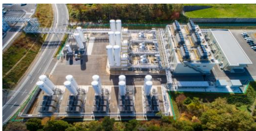
半導体産業に窒素を供給する ASU(空気分離装置)
