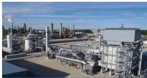
水素を供給する HyCO プラント
