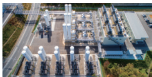
半導体産業に高純度窒素を供給するASU(空気分離装置)
