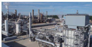
水素を供給するHyCO*プラント
