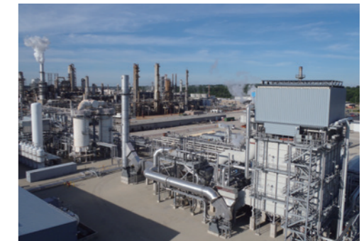
水素を供給するHyCOプラント
