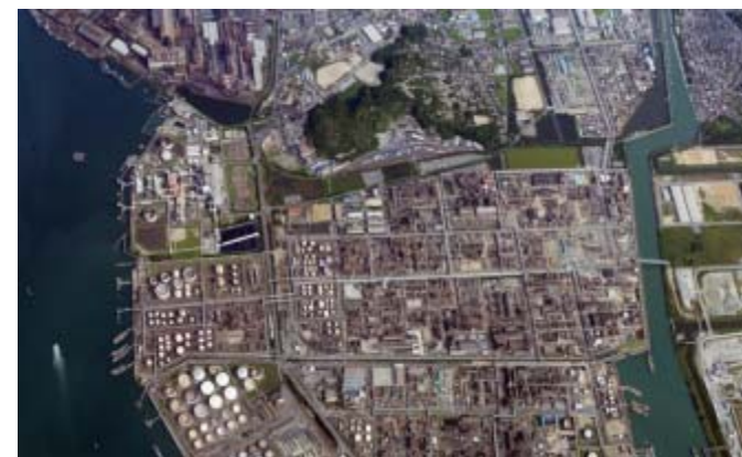
Mizushima Plant, MCC
